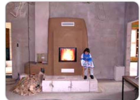
Fertiger Lehmofen in Betrieb
